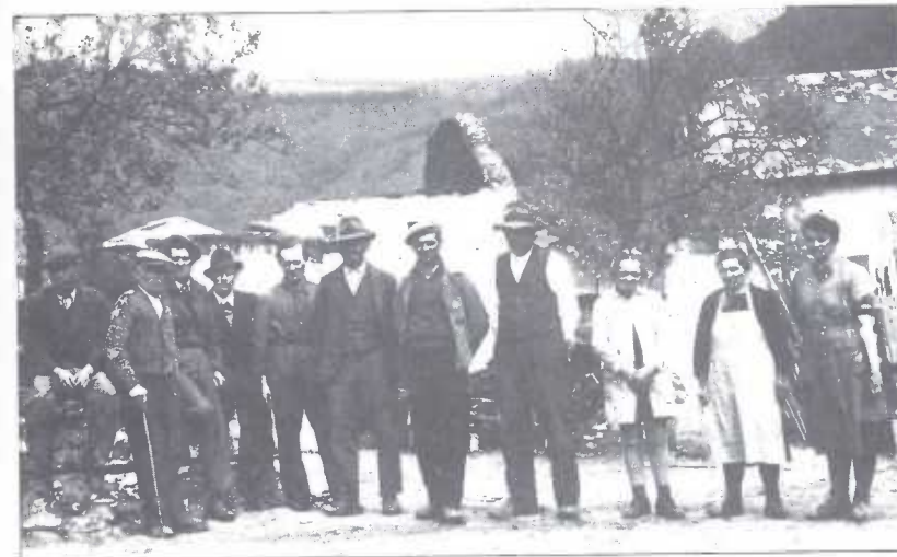
Ein Teil der Dorfbevölkerung beim Wiederaufbau
